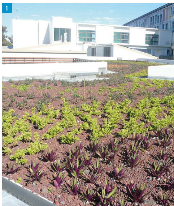
1. Toiture végétalisée sur un hôpital, Le Tampon
